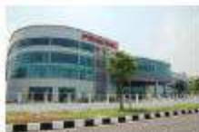
Pensonic factory, Bukit Minyak, Penang
